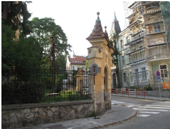
obr.02 Pohľad na portál z Moyzesovej ulice
