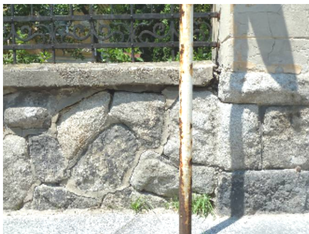
Foto č.9 – pohľad z ulice
