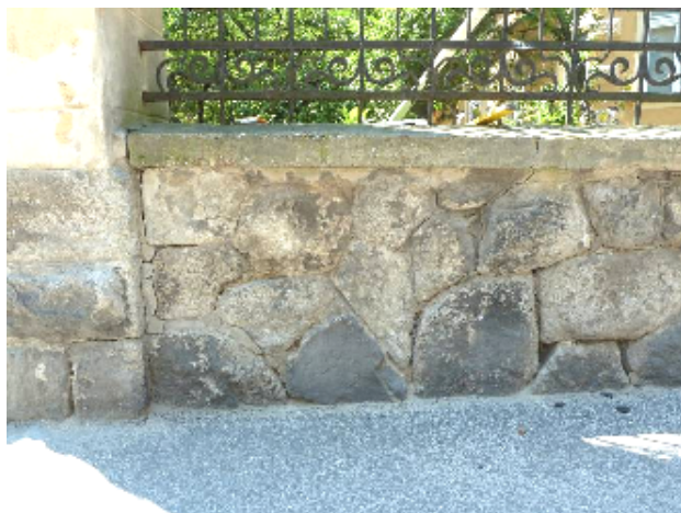
Foto č.11 – pohľad z ulice
