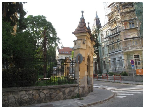
obr.02 Pohľad na portál z Moyzesovej ulice
